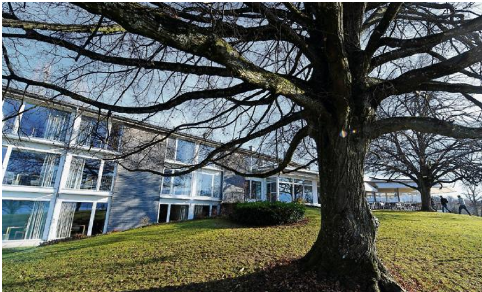
Bis 2017 wird das Hotel Boldern noch saniert – die erste Etappe konnte jedoch bereits abgeschlossen und deren Resultate der Öffentlichkeit präsentiert werden.
